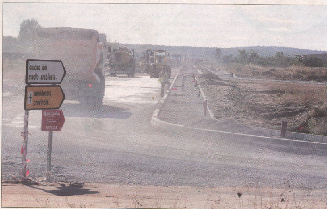
Camino de accesos al aeródromo con los camiones trabajando en la urbanización de la CMA. / VALENTÍN GUISANDE
